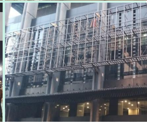
Infraestructura Corporativa Construcción e instalación de superestructura metálica para pantallas LED
